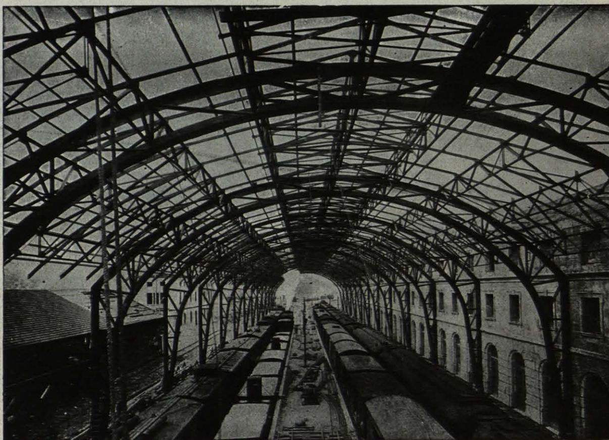
Estación internacional de Port-Bou.—Cubierta de andenes.—Agosto-Diciembre 1928.
